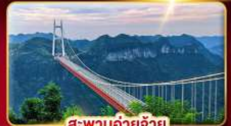
สะพานอ้ายจ้าย
