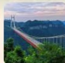
สะพานอ้ายจ้าย
